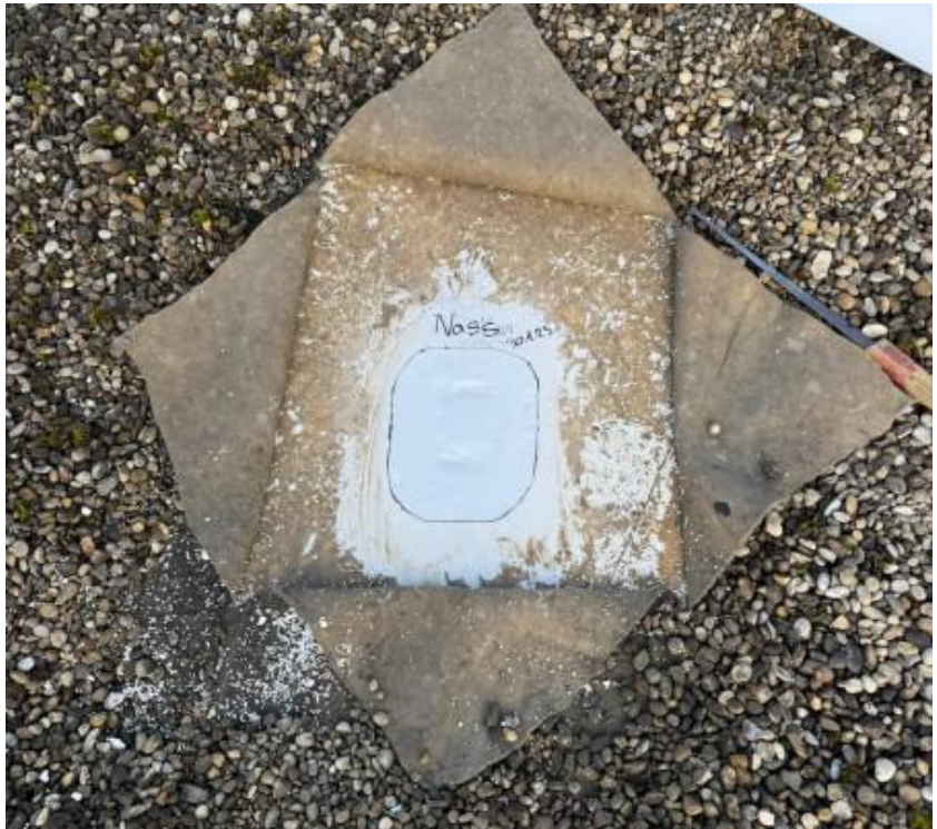
Sondage Bild 5 -Verschliessung der Dachhaut mit PVC Flansch am 30.01.2025
