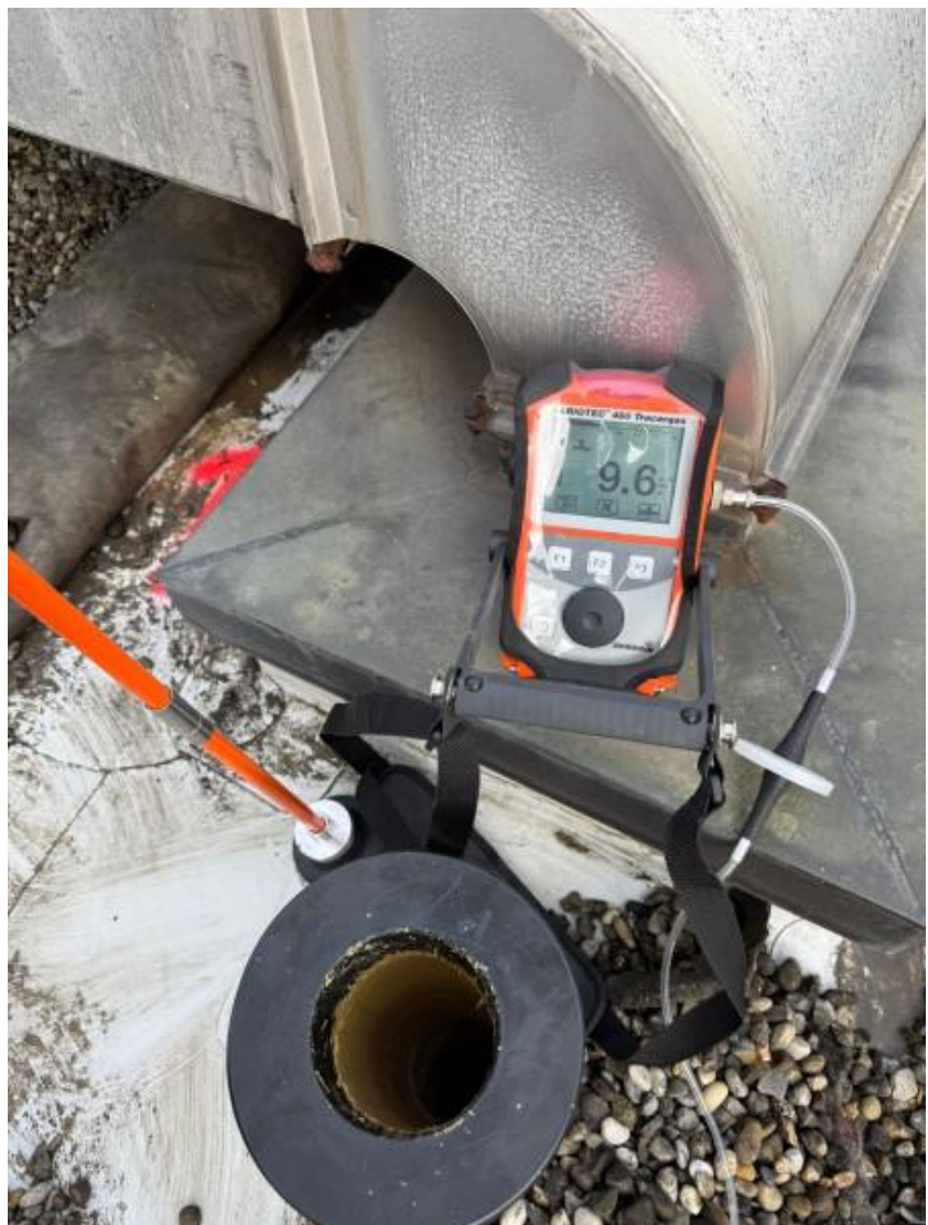
Abschnitt E: Beschädigung 2
