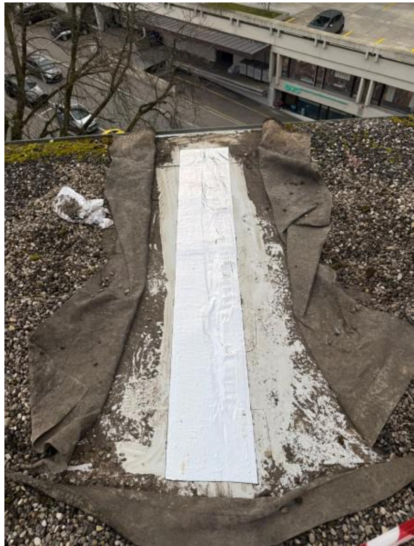
Abschnitt F: Beschädigung 3 – 2 Meter langer Schnitt in der Dachfläche
